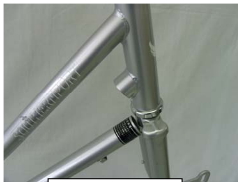
No.08 下パイプ破断
