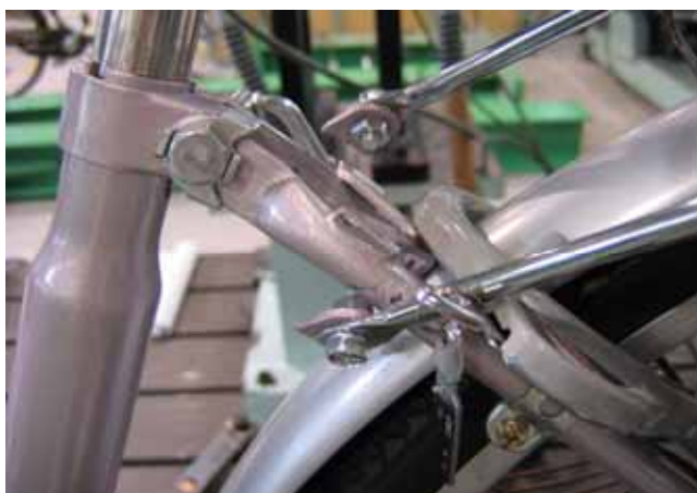
写真 4.6-3 上ブリッジ破損状況
