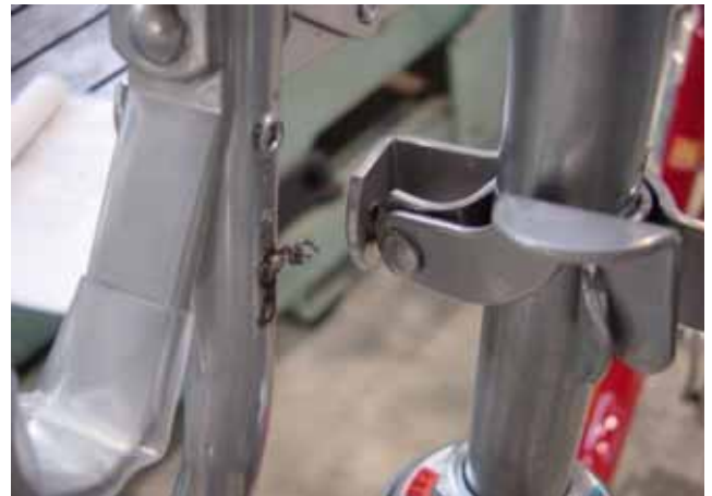
写真 4.5-3 かしめ部破損状況
