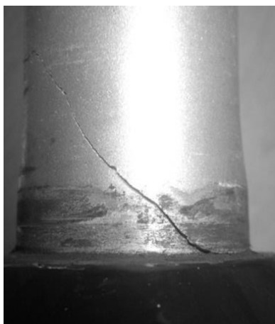
写真 13 BMX No.2 亀裂の様子
