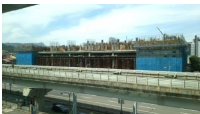
建設中の南港二館
