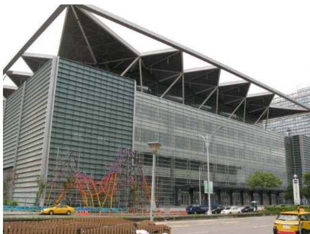
建設中の 2 号館
